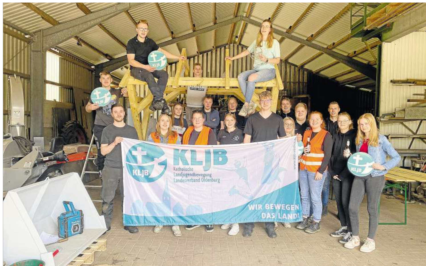
Die KLJB Peheim will hoch hinaus: Die Ortsgruppe baute während der 72-Stunden-Aktion eine überdachte Sitzgelegenheit. Foto: KLJB
